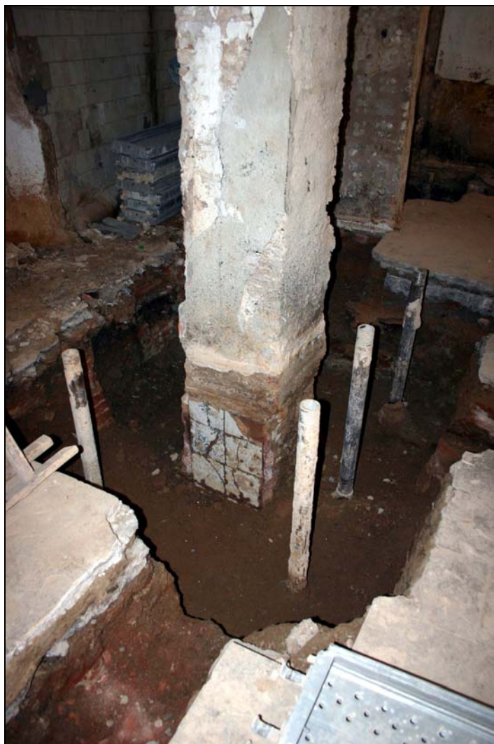
Foto 3. Imatge del sondeig 2. S'aprecien les restes d'estructures relacionades amb el clavegueram.
